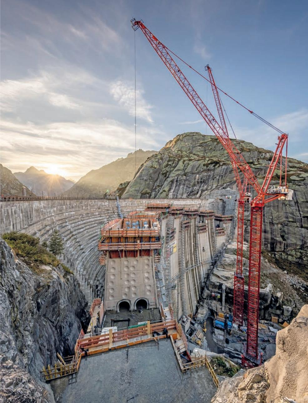
**Die neue Mauer wird parallel zur bestehenden errichtet, um die fortlaufende Stromproduktion am Grimselsee gewährleisten zu können.**
